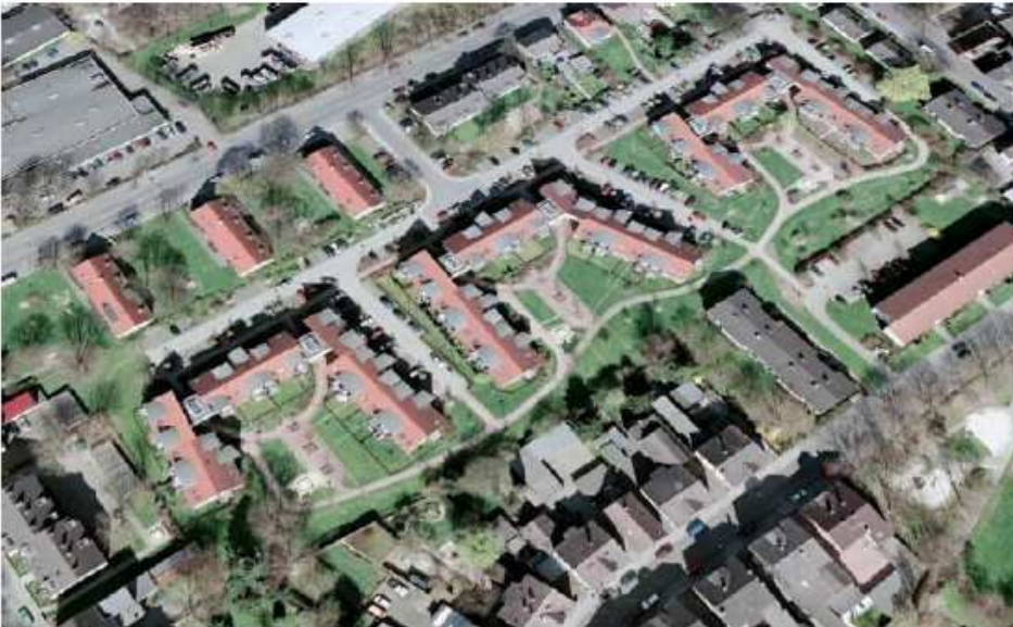
Errichtung von 126 öffentlich geförderten Wohnungen
